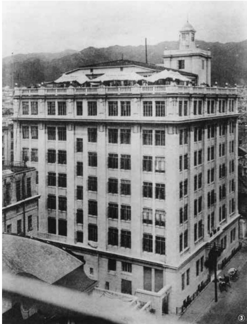
明海ビルは1921(大正10)年に竣工した RC造8階建てで日本における最初の超高層ビルだったという
